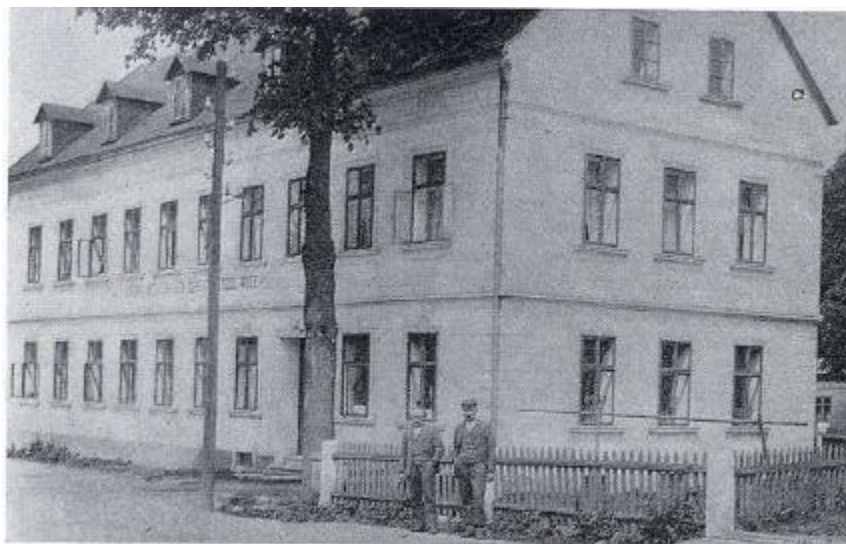
Die frühere „Richter-Wenzel“ Knopf- und Metallwarenfabrik
